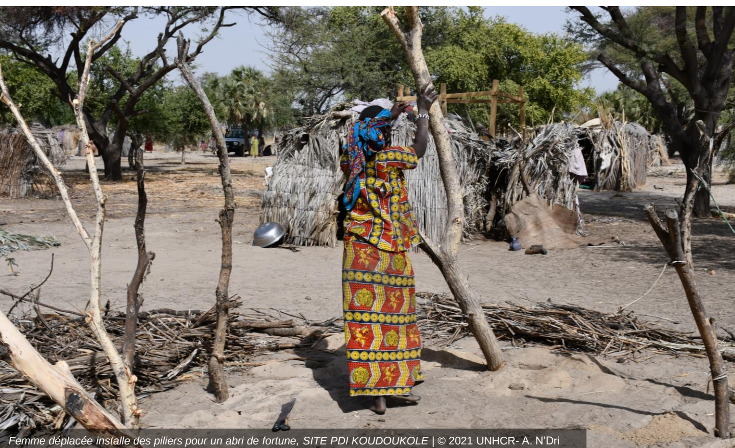
Construction d'un abri de fortune en cours , SITE PDI MELEA DJOUROU | © 2021 UNHCR- A. N'Dri
