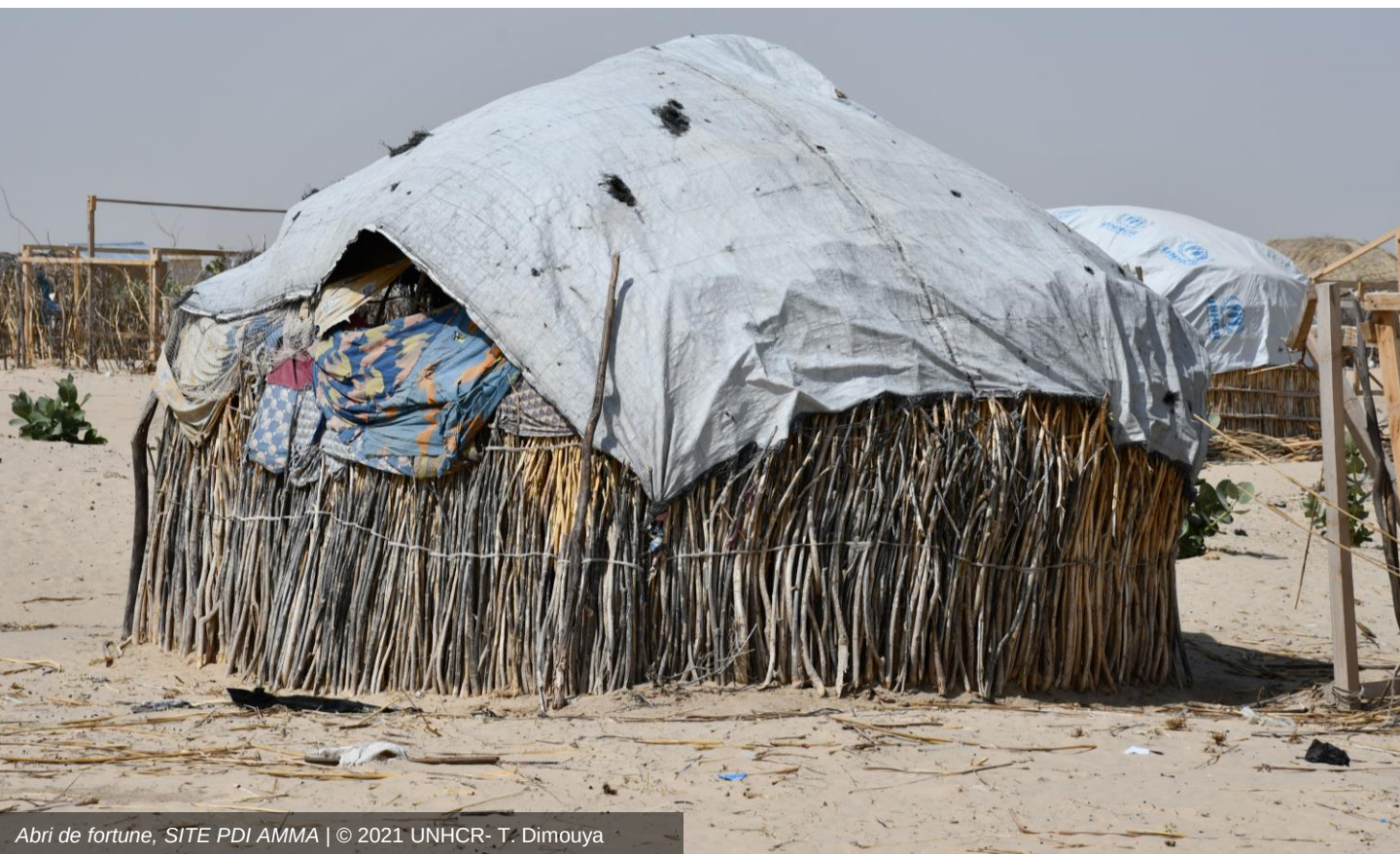
Abri de fortune en cours de construction, SITE PDI NGOROROM | © 2021 UNHCR- A. N'Dri
