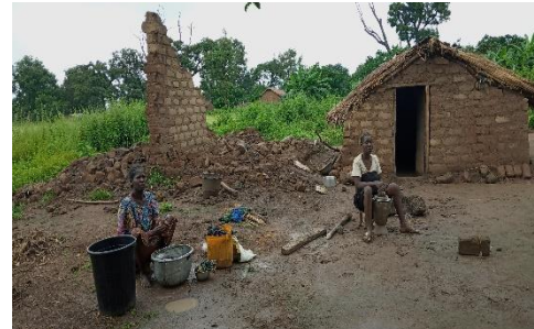
Maison écroulée au village Farazala dont la propriétaire a utilisé les débris pour faire une petite hutte afin de s'abriter de la pluie
