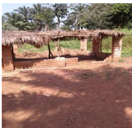
Hangar aménagé pour les cours
